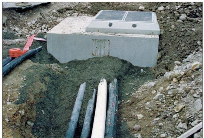
Abbildung: Typ **KB4S2x1.S** Kabelschlaufkasten mit Betonrand-Schachtabdeckung B4S, Belastbarkeit der Schachtabdeckplatte Typ S: B 125, 13.5 t
