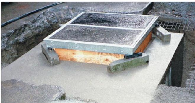
Abbildung: Typ **K4S2x1.S** Kabelschlaufkasten mit PR4S-Schachtabdeckung
